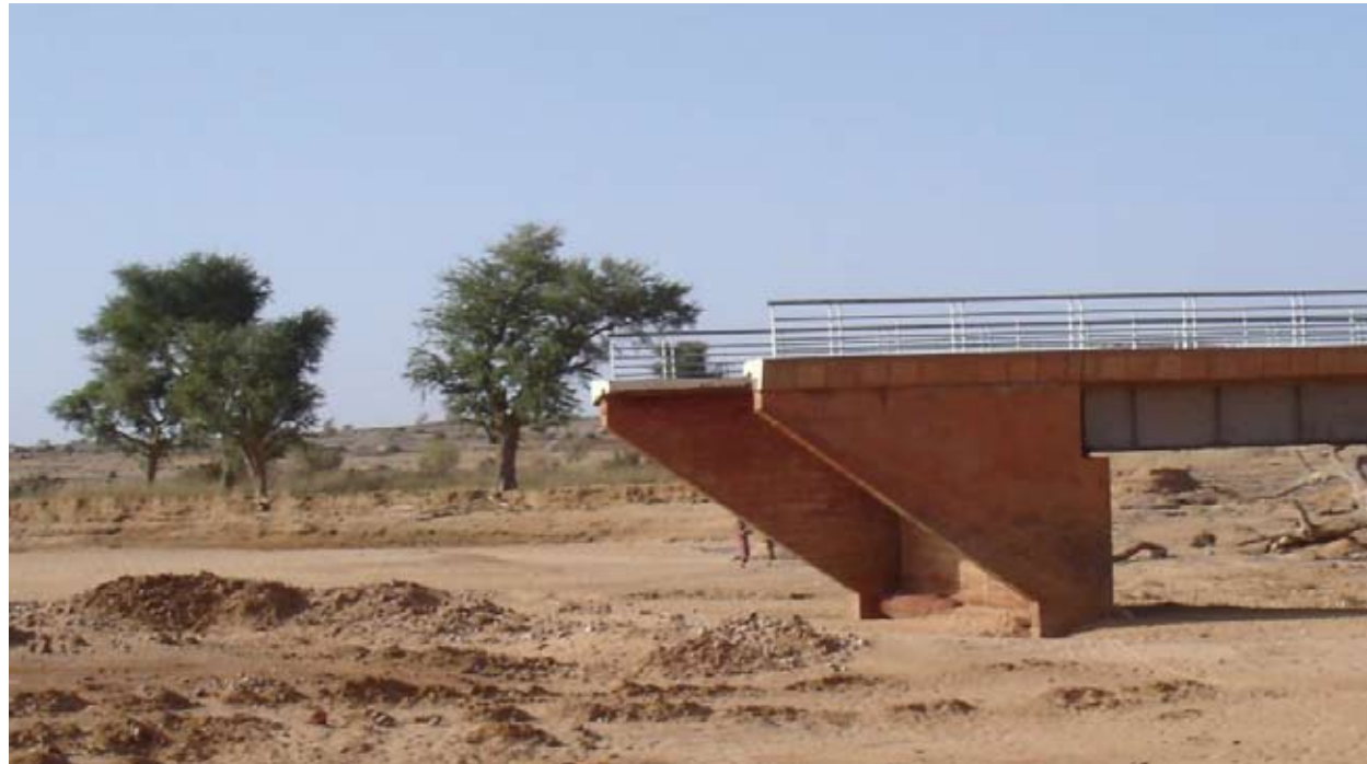
Pont de la route de Bandiagara détérioré lors d'une crue
