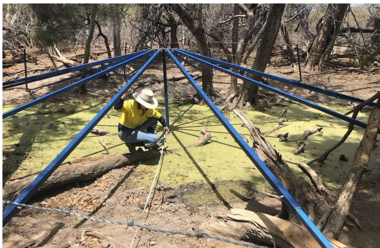
Source : Identification d'une nouvelle source, ABC
